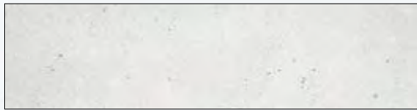
Parveketaustan maalauskäsittely rakennus A
