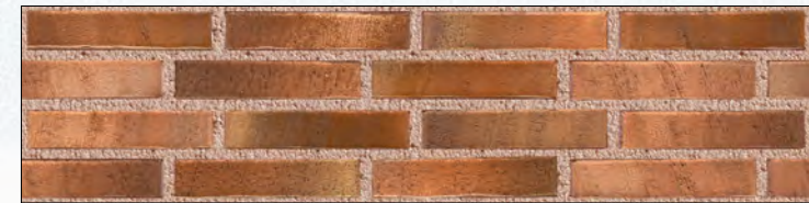
Tiililaatta rakennus A
