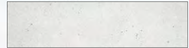
Parveketaustan maalauskäsittely rakennus A
