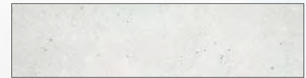
Parveketaustan maalauskäsittely rakennus A
