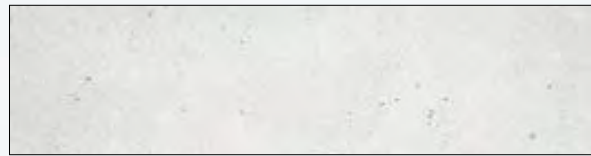
Parveketaustan maalauskäsittely rakennus A
